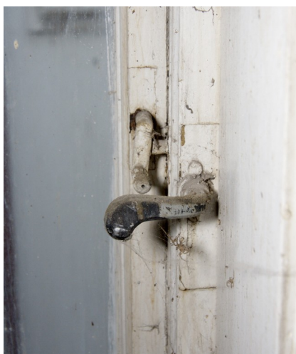
Detail uzavírání větracího okénka této výplně
