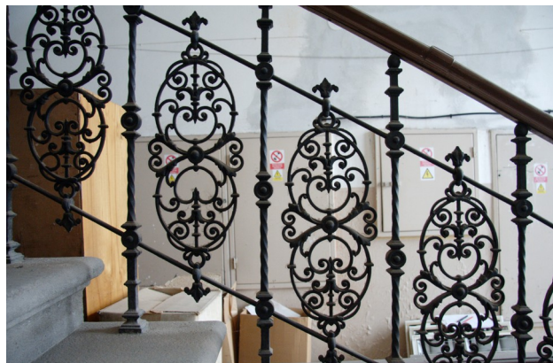
Litínové zábradlí schodiště D1.01
