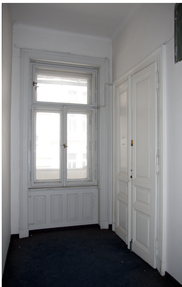
Původní okenní výplň s deštěnou nikou v chodbě D4.15
