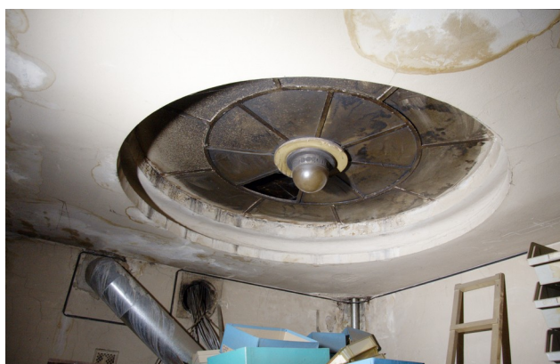
Kovová stropní okenní výplň prostory A1.35
