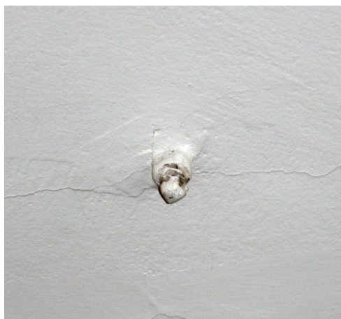
Zaslepený rozvod osvětlovací plynu ve stopě místnosti B4.01
