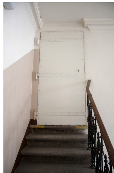
Kovové dveřní výplně Na schodištích A5.01 a D4.01
