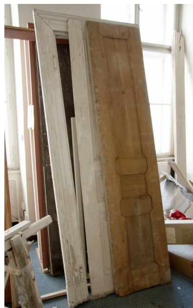
Rozebrané části zárubní v místnosti D1.11
