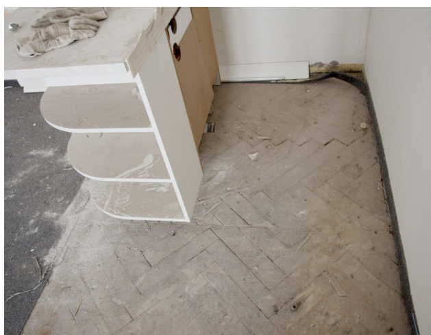
Dodatečné napojení podlahy z parketových vlýsů v místě odstraněné příčky v místnosti C3.03
