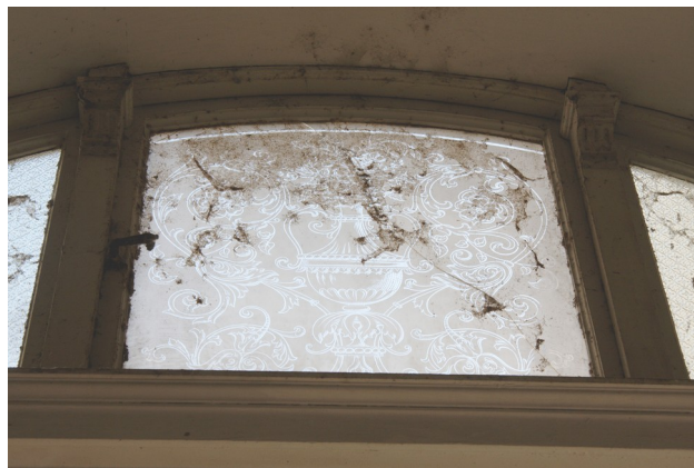
Detail dochovaného nadsvětlíku vrat v průjezdu A1.15 do prvního dvora, zdobeného leptaným sklem
