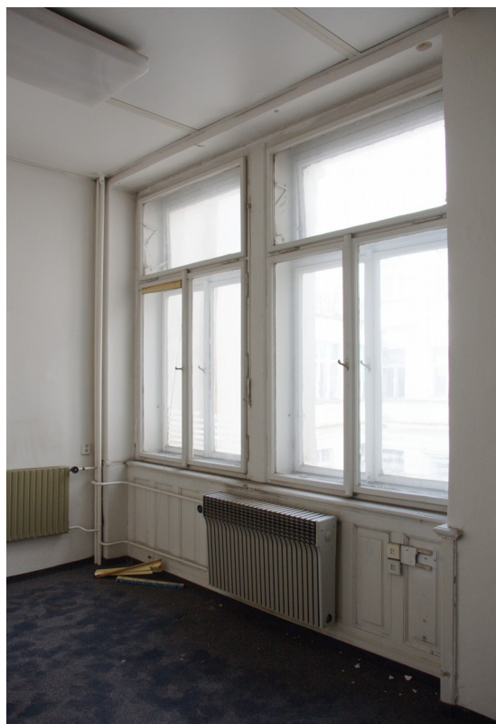
Okenní výplň s deštěným parapetem v místnosti G2.02
