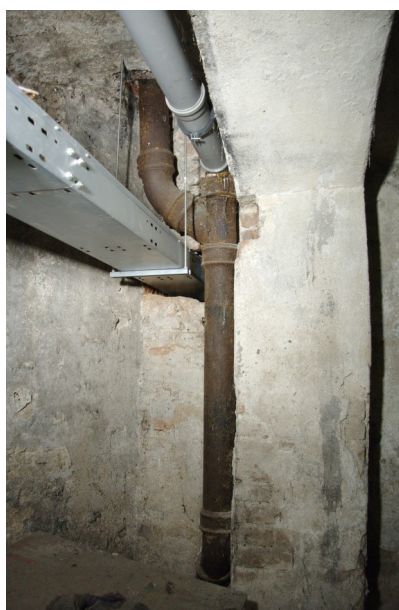
Z části původní litinový odpad v prostoru A01.02
