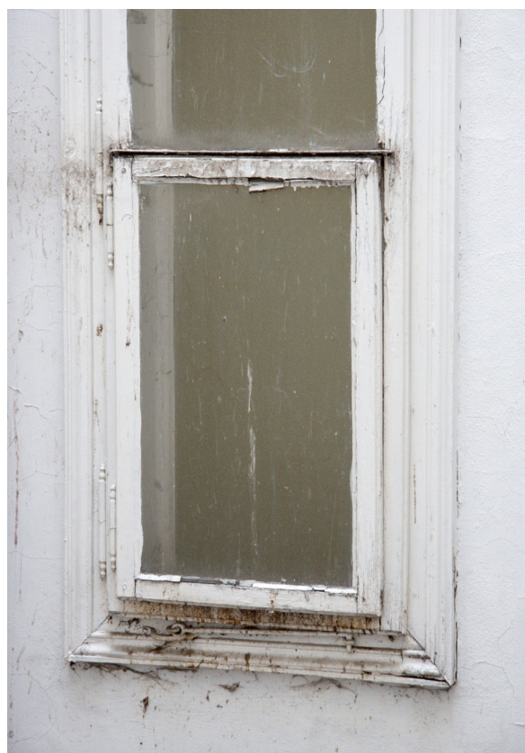
Detail větracího okénka této výplně
