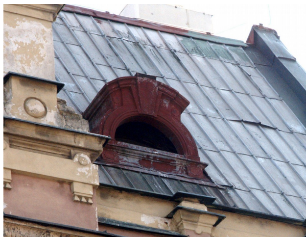
detail plechového střešního vikýře nad průčelím
