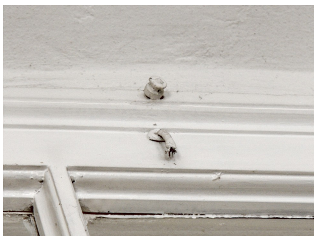
Pozůstatky elektrického rozvodu v prostoru G3.01, patřně z počátku 20. století.
