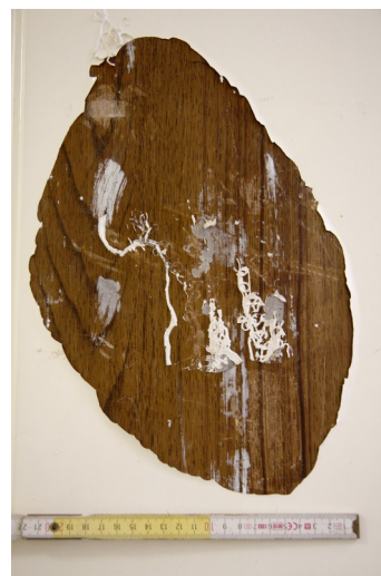
Původní fládr dveřní výplně v chodbě A4.19-c
