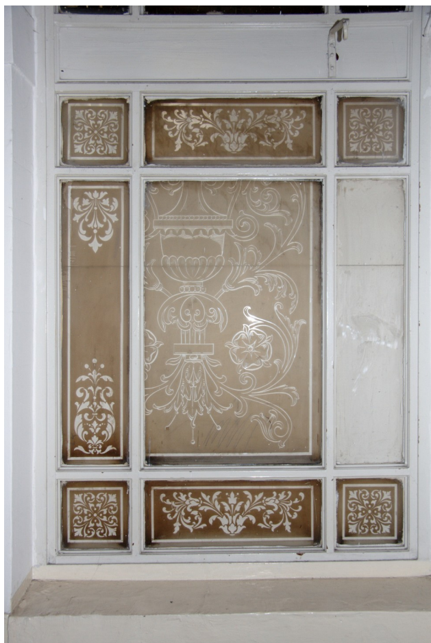
Detail leptané okenní výplně ve schodišti A1.01
