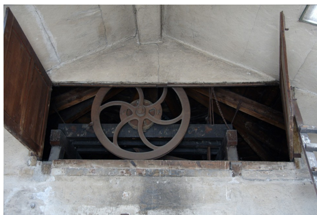
Dochovaná část mechanismu výtahu v prostoru G4.02
