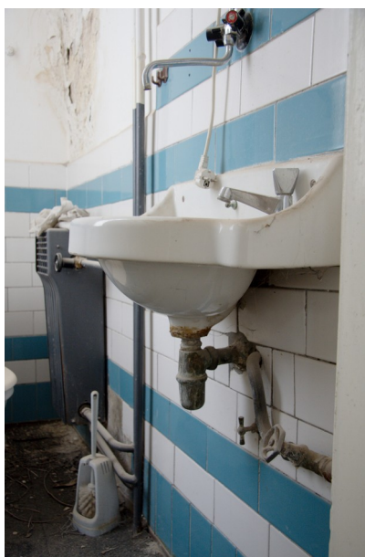
Umyvadlo a olověný vodovod v místnosti G2.08, pravděpodobně ze třicátých let 20. století
