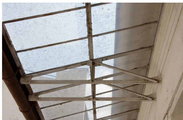
Ocelová konstrukce prosklené střechy nad pavlačí D4.02
