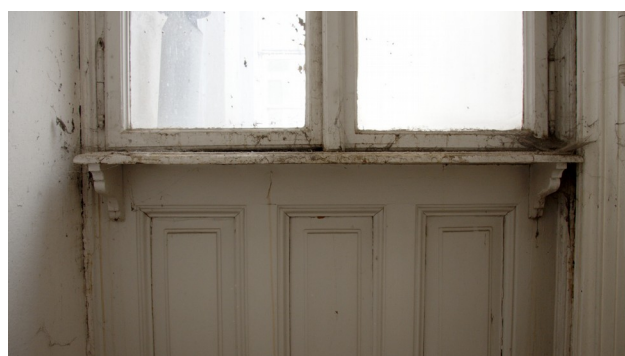
Detail parapetu prosklené příčky v místnosti D2.08
