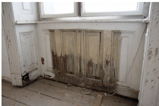
Detail deštění niky s patrným fládrem v místnosti C2.01
