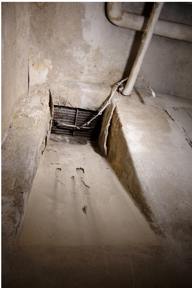
Pozůstatky upevnění mříže přisvětlovacího otvoru v prostoru D01.13
