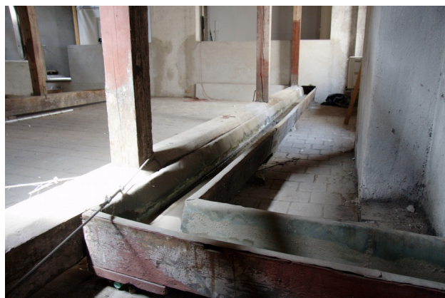
Žlab odvádějící dešťovou vodu půdním prostorem A6.04 ze střechy průčelní budovy do odpadu situovaného v prostoru světlíku
