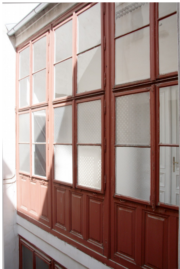
Prosklená dřevěná stěna ve světlíku A5.26
