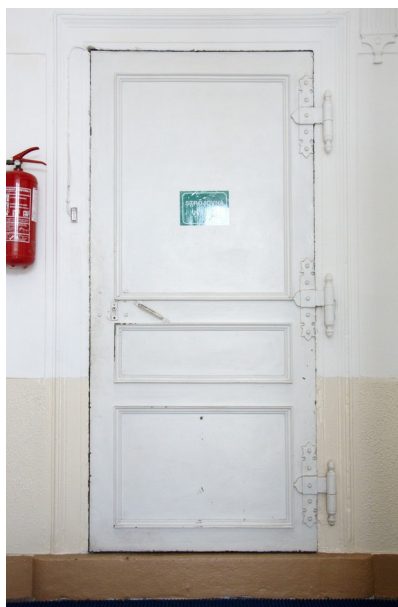
Detail kovové dveřní výplně v prostoru A6.01
