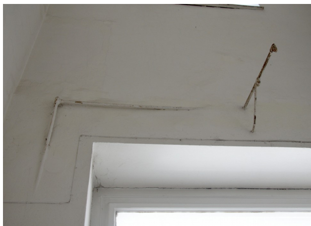
Rozvod osvětlovacího plynu nad podestou D4.01
