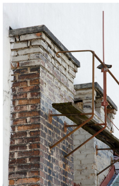
Původní komínové lávky nad křídlem F
