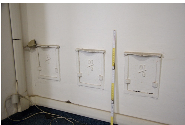
Komínové čistící otvory s původními litinovými kryty
