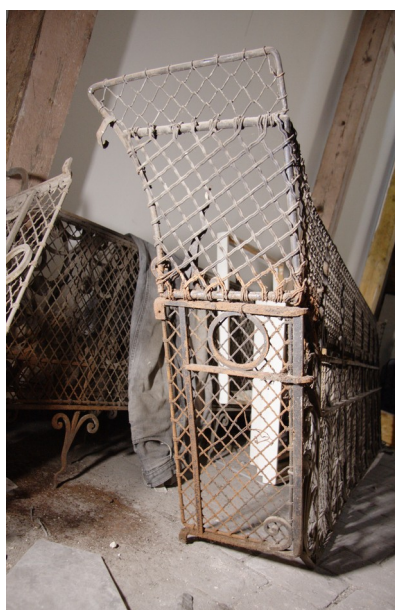
Kovové sítě z roku 1933, navyšující zábradlí v okolí osobního výtahu a svým tvarem odpovídající tvaru vstupu do výtahové kabiny, uložené v prostoru A6.01
