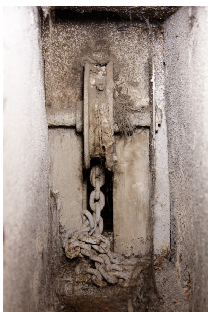
Část mechanismu, kterým byl výtah ovládán
