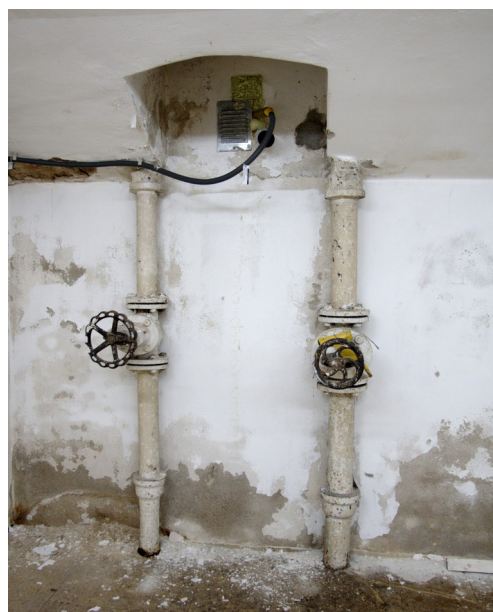
Pravděpodobně původní, patrně plynové potrubí v prostoru A01.06
