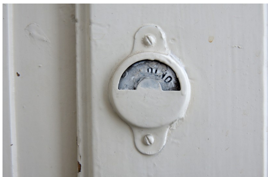
Dodatečné uzavírání „záchodového“ dveřního křídla v místnosti D4.06 z doby první republiky
