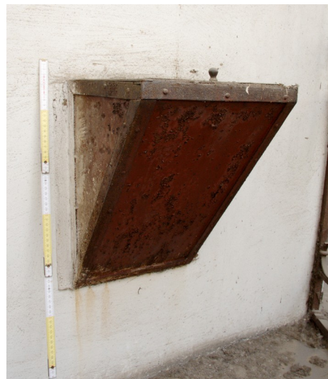
Násypný otvor shozu na popel na pavlači D2.02
